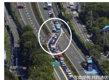
熊本地震による九州自動車道通行止めの早期解消に貢献しました
