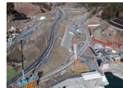
震災復興の道路整備と宅地造成に従事しています
