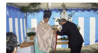
中四国支社社屋起工式の様子
