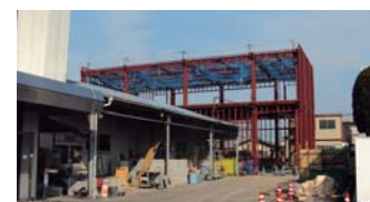
工事が進む試験棟の様子
