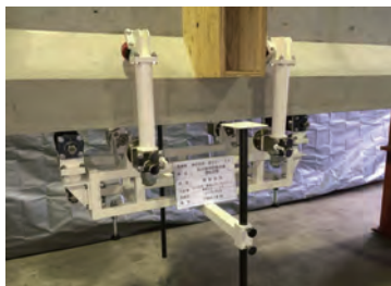
ロボットによる橋梁点検の様子
