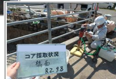
コンクリート構造物からのコア供試体採取
